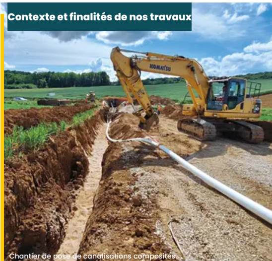
Chantier de pose de canalisations composites.
