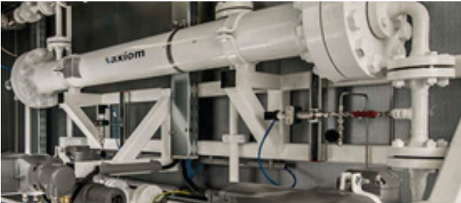
Séparation GN et H 2 par membrane polymère
