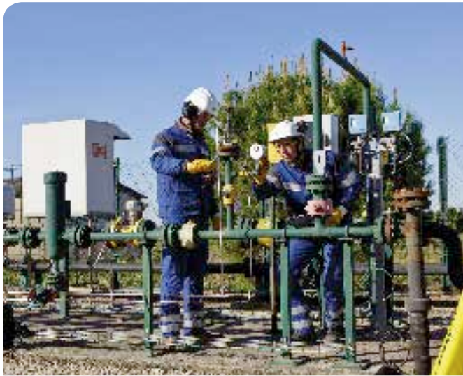
Essais de fonctionnement sur un poste de livraison
